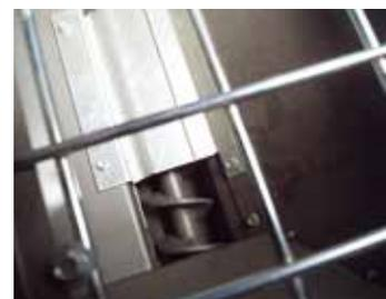
Abb.: Förderschnecke im Pellet Vorratsbehälter
